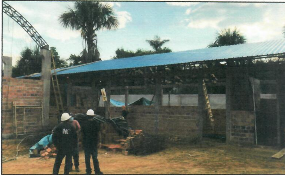
FOTO N° 08: INSTALACIÓN DE COBERTURA CORRUGADA EN MODULO I Y MODULO IV.
