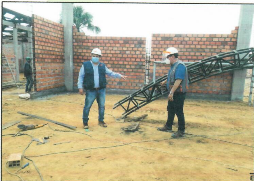
FOTO N°02: TRABAJOS DE ESTRUCTURAS METÁLICAS EN PATIO DE FORMACIÓN, MODULO V.
