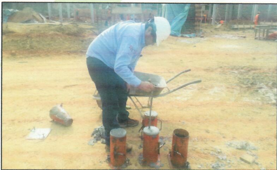
FOTO N°10: MUESTREO DE MORTERO EN PROBETAS, PARA LUEGO VERIFICAR RESISTENCIA A LA COMPRESION DE CADA UNO DE LOS ELEMENTOS ESTRUCTURALES VACEADOS EN OBRA.
