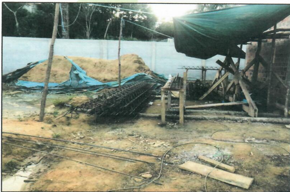
FOTO N° 04: VIGUETAS METALICAS DE PATIO DE FORMACIÓN.
